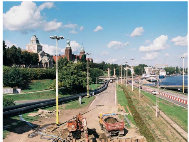
Fot. 4. Przewiert pod rzeką Odrą – Szczecin
