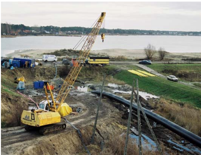
Fot. 3. Przewiert pod Martwą Wisłą – Gdańsk
